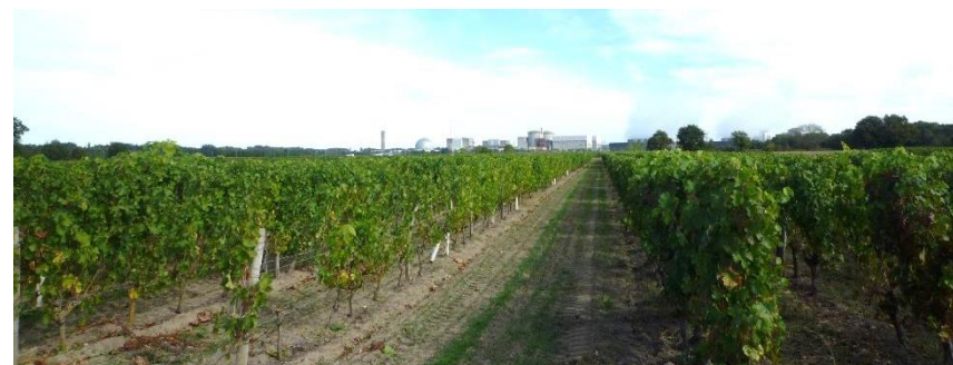
La plaine viticole du Véron dominée par la silhouette de la centrale nucléaire
