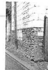
Soubassement réalisé quelque fois en pierre
