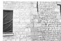
Transition dans la façade entre un mur ravalé, rejointoyé et l'ancien mur.
