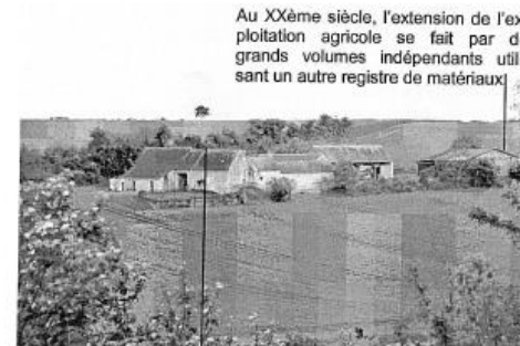
Au XXème siècle, l'extension de l'exploitation agricole se fait par de grands volumes indépendants utilisant un autre registre de matériaux. Bâtiments aux volumes variés mais liés entre eux jusqu'au XXème siècle, traitement en petits volumes
